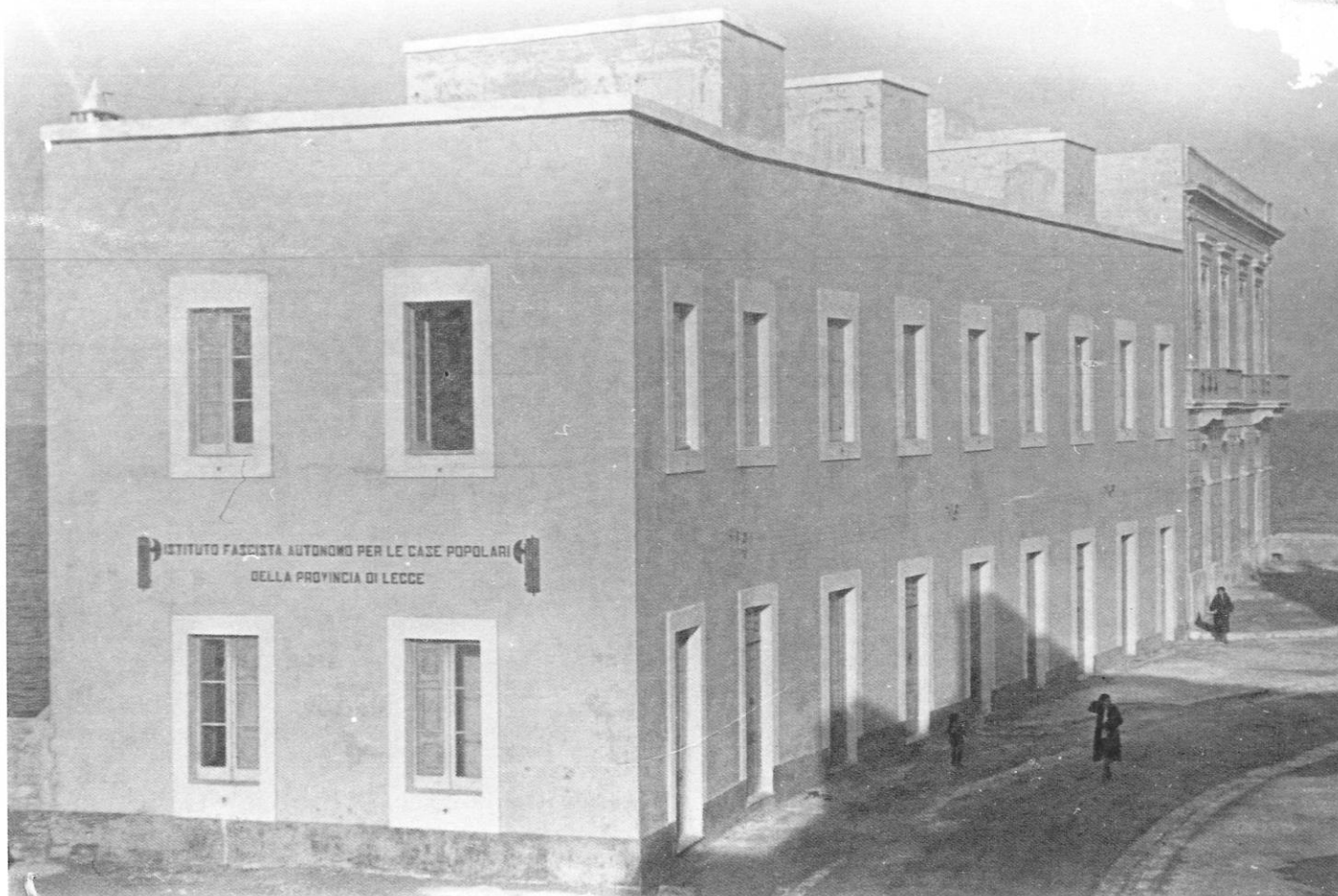
Uno dei primissimi edifici dell'IACP di Lecce
