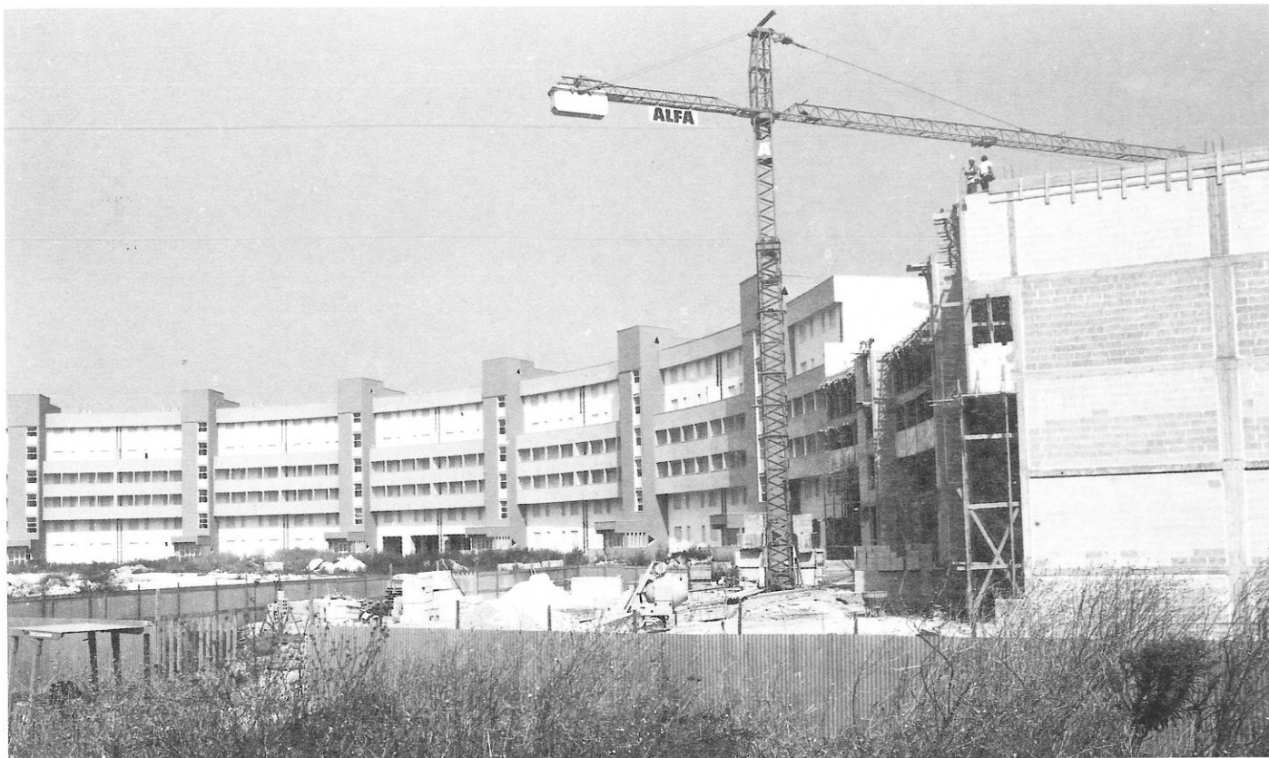
Lecce - Cantiere - n. 34 alloggi - 4° biennio
